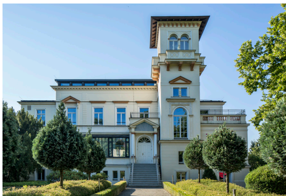
Straßenansicht der Villa Bergmann in der Berliner Straße in Potsdam
